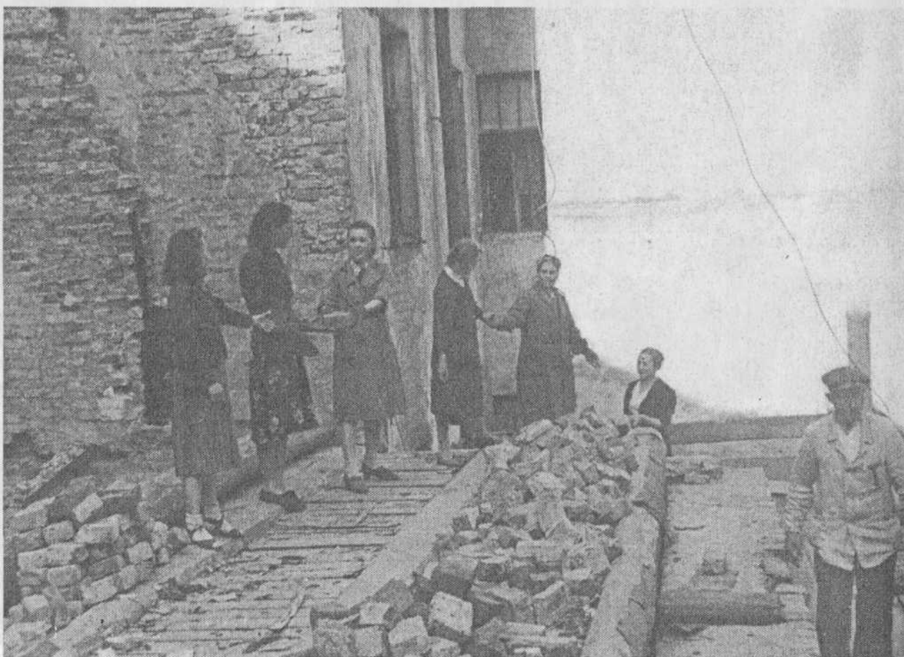
РАБОТЫ ВО ДВОРЕ ДОМА № 23 ПО УЛ. ЧАЙКОВСКОГО
