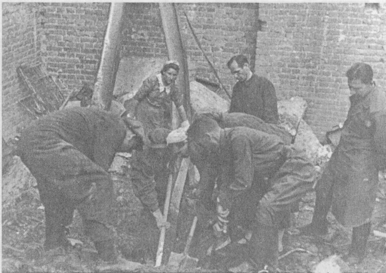
РАБОТА ПО ЗАГОТОВКЕ СТРОИТЕЛЬНЫХ МАТЕРИАЛОВ (БАЛКИ ДЛЯ ВОССТАНОВЛЕНИЯ ДОМА № 27 ПО УЛ. ЧАЙКОВСКОГО)
