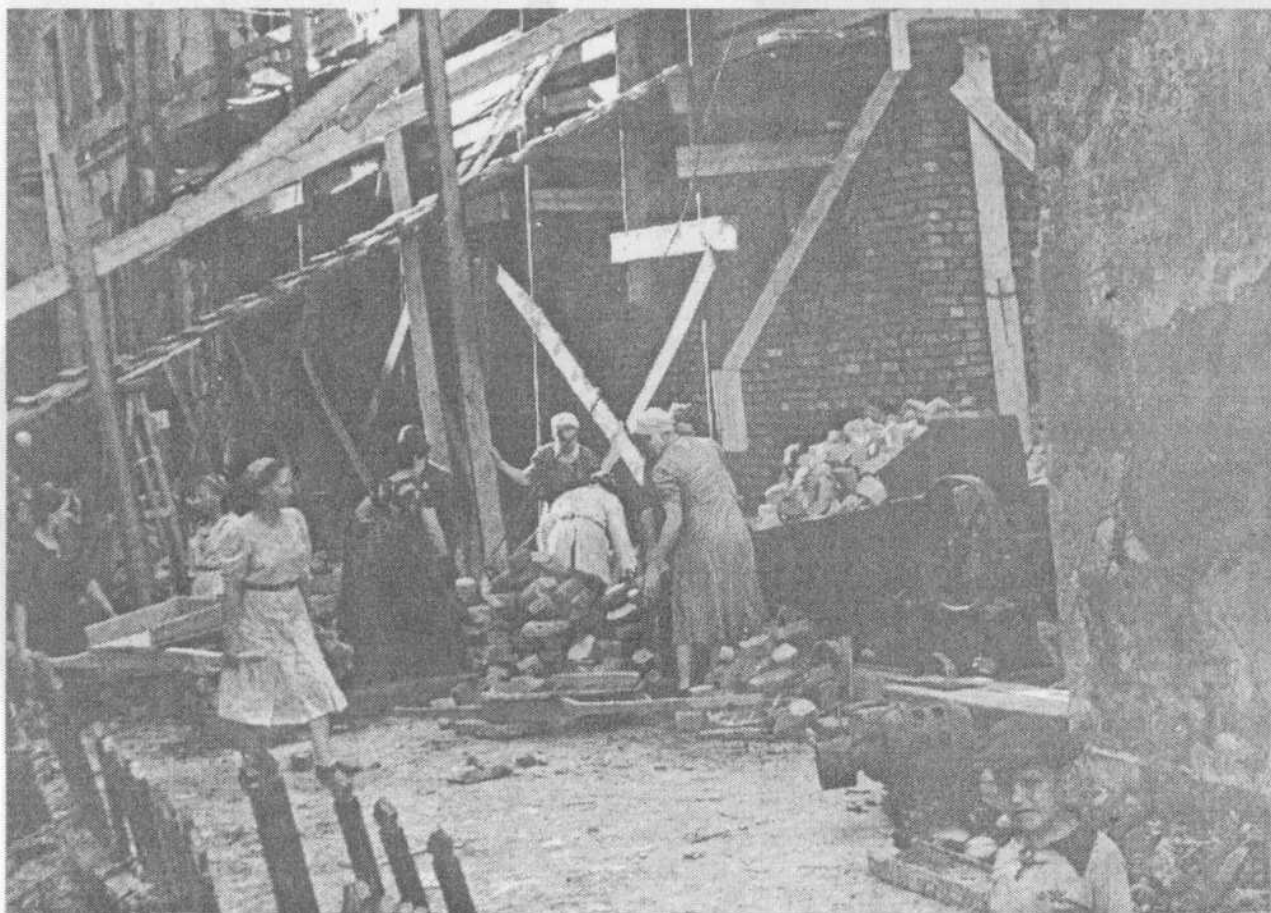
Дом № 33 по ул. Чайковского. Ремонт здания. Отдел "Б"
