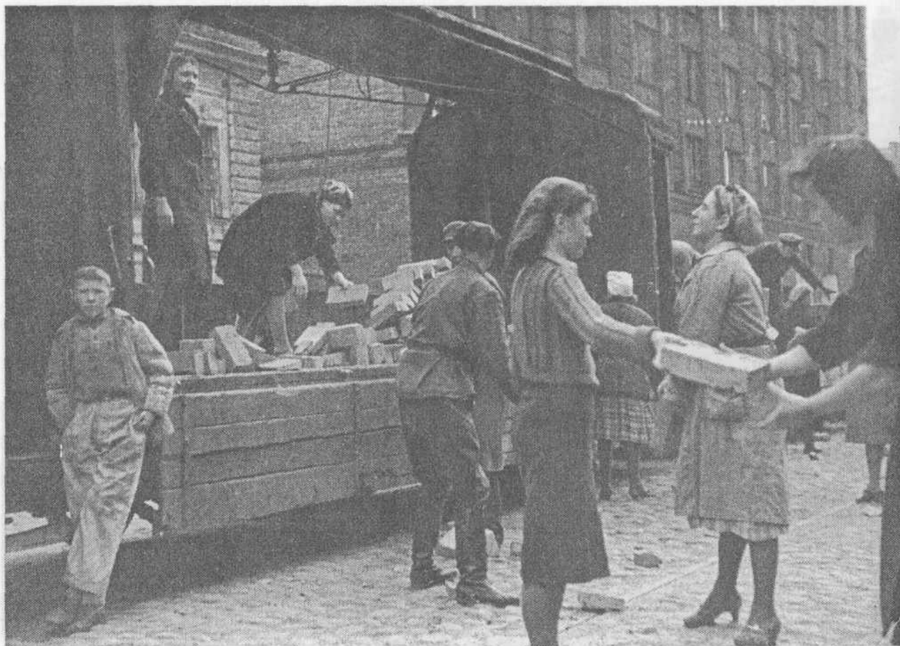
Разгрузка кирпича на пр. Чернышевского. Отдел "Б" и спец. отдел
