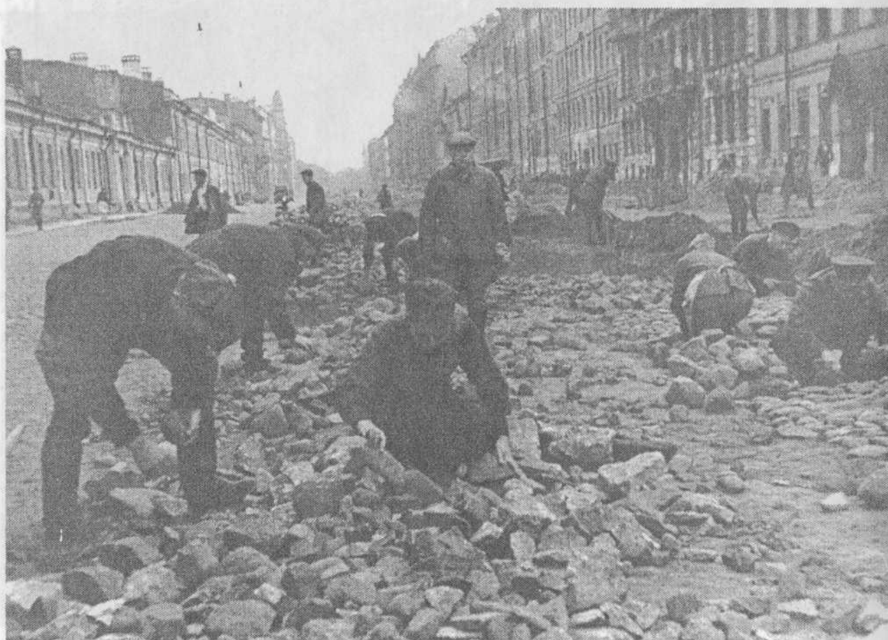
Работы по мощению на ул. Каляева
